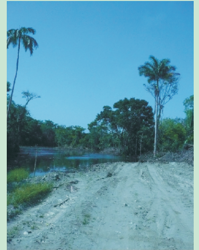
Construcción realizada dentro del Parque Nacional y Sitio RAMSAR Jeannette Kawas, como parte del Mega proyecto Bahía de Tela
